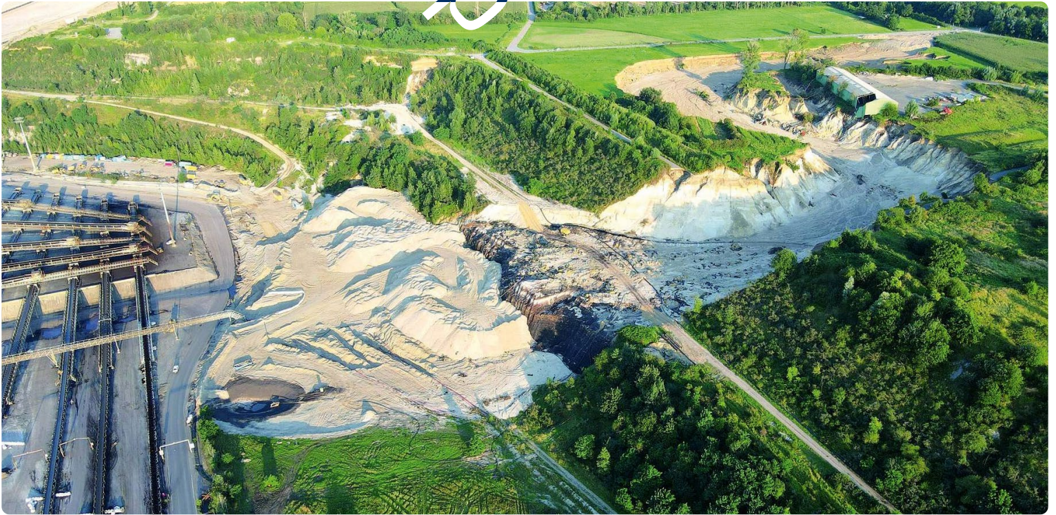
Die Hochwasserkatastrophe 2021 hat tiefe Spuren hinterlassen. Hier sind die Folgen des Wassereintruchs in den Tagebau Inden zu sehen.
