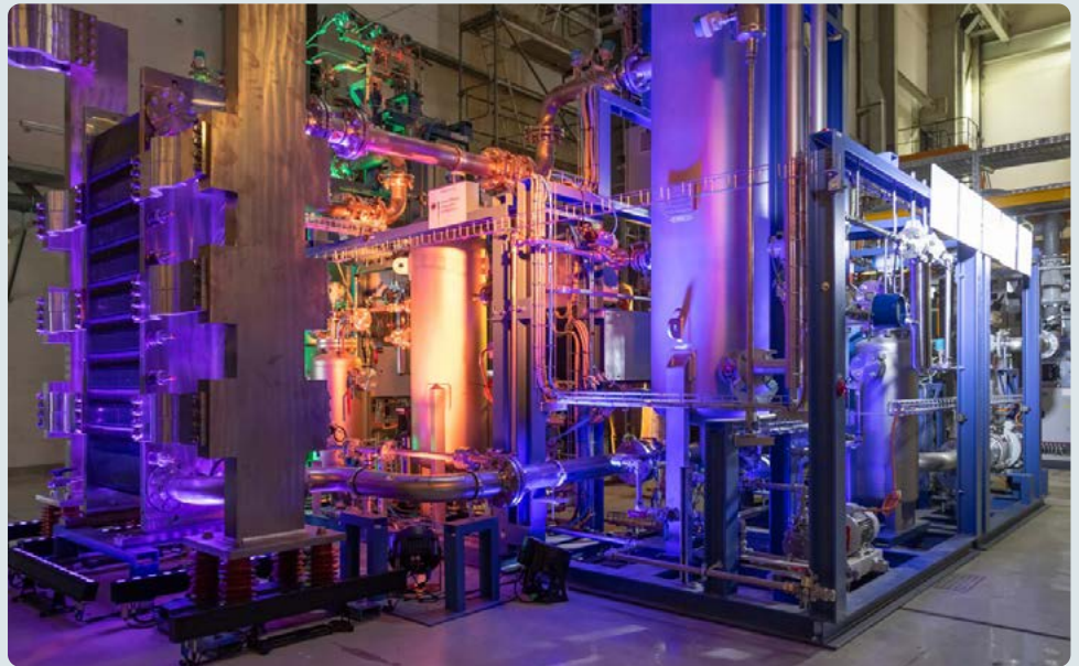
* ENERGIEWANDLER – DE-R isking PEM- E lektrolyseur. Erforschung der Degradations-, Fehler- und Schnittstellenmechanismen auf allen technischen und ökonomischen Ebenen.
